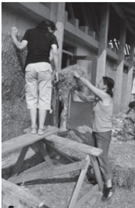
Omietanie izolačných materiálov na obvodovej stene hlinenou omietkou s prídavkom kobylincov (konského hnoja).
