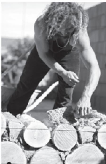
Stavba obvodovej steny prístavby technikou Corwood – odkôrnené drevené polená sú priečne ukladané a spájané maltou.
