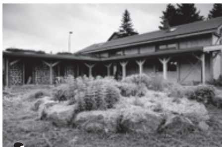
Finálna podoba zrekonštruovaného Ekocentra.
