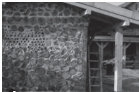
Výsledná podoba drevenej obvodovej steny. Čelá klátikov sú na fasáde priznané, stena tak pôsobí veľmi dekoratívne. Na niektorých miestach sú klátky nahradené sklenenými fľašami, čím vzniká zaujímavé okno.
