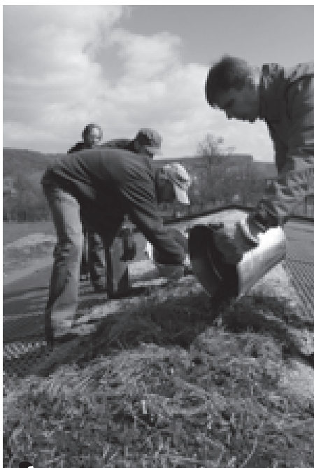
Dobrovoľníci pomáhajú zatravnňovať strechu.
