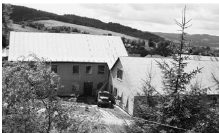
Projekt zateplenia podkrovných priestorov ZŠ v obci Rabča foto:
