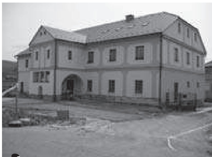
... a dnes, keď sa stavebné práce chýlia k záveru
