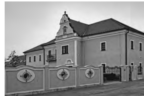
Pohľad na rekonštruovaný faru – bývalé sídlo Boronkaiovcov
